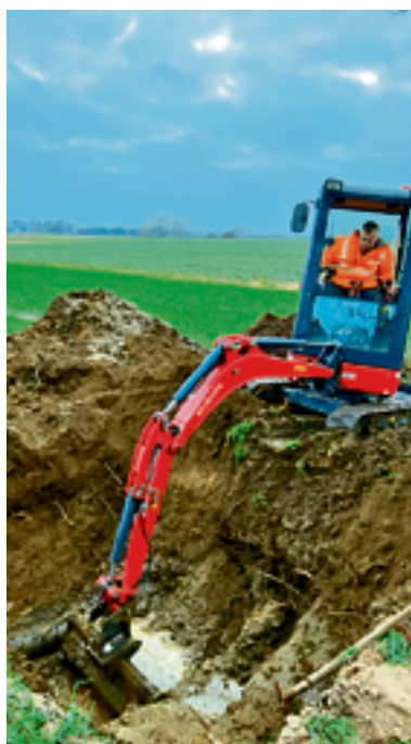
▲ Dank großer Technik konnte der Schaden an der Versorgungsleitung schnell behoben werden. Foto: ZV
